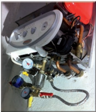
Die Installation auf Heizkessel
