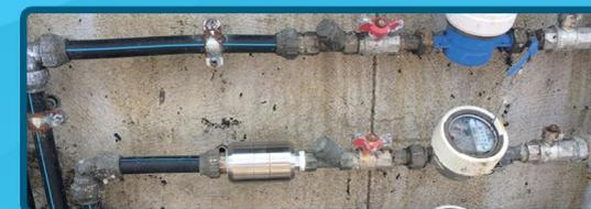
После установки, благодаря эффекту магнитной поляризации, образовавшаяся накипь начинает отделяться, очищая трубопровод и остальные составляющие элементы (котлы, бытовые электроприборы и другое оборудование), что в дальнейшем может стать причиной появления небольших остатков в виде крупиц.
